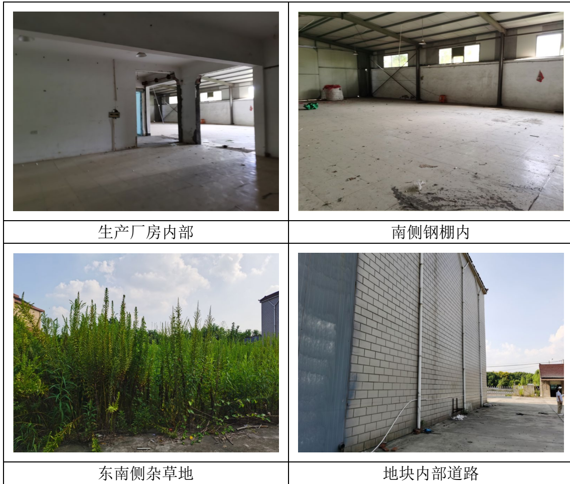
图 2.4-1 地块内现状照片
