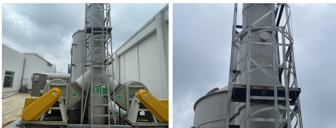
图 4-4 二级活性炭废气处理设施及进出口采样点位
